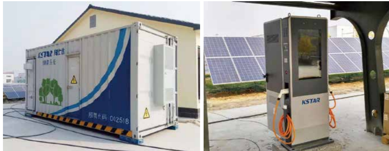
► 50 kW/200 kWh BESS für EV-Ladestation in Hebei
