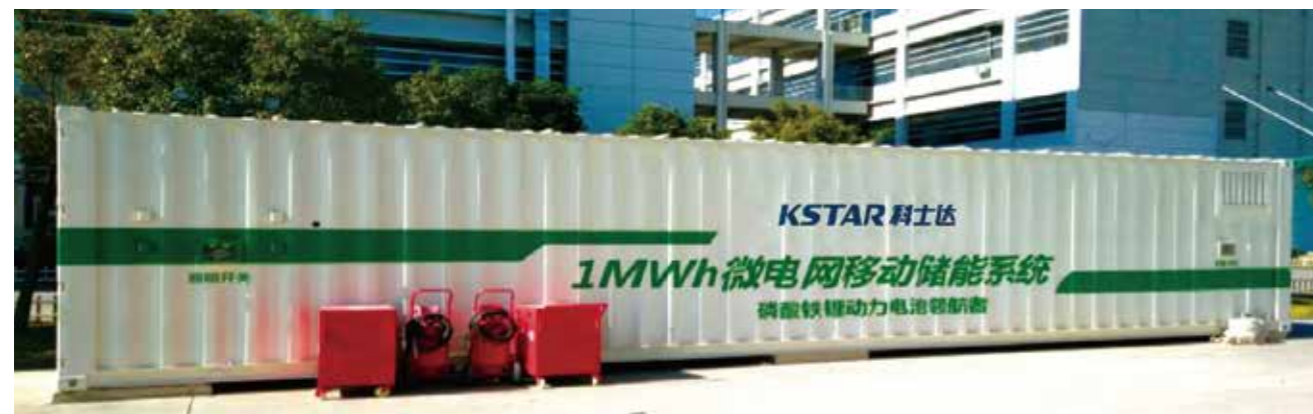
► 3 MW/12 MWh BESS-Demonstrationsprojekt in Shenzhen
